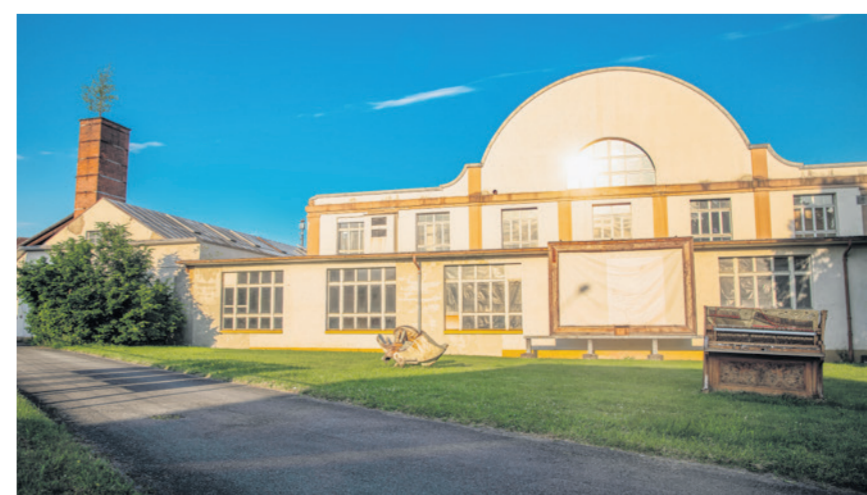
Die schützenswerte Ofenhalle (rechts) ist insbesondere von aussen markant.
