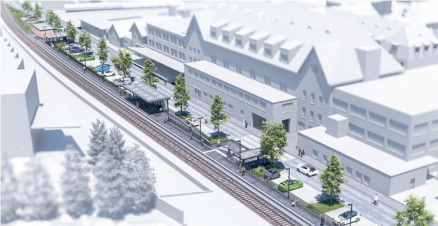
Der Zugang Süd des neuen Bahnhofs ist so gewählt, dass der westliche Ausgang der Porzellangasse (siehe Bildmitte) praktisch punktgenau in den neuen Perron-Zugangsbereich mündet. Alle Visualisierungen: zvg/BLS Netz AG
